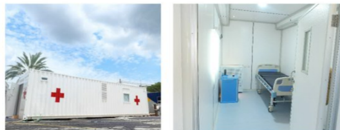
Proj. HVAC Isolation Room Aceh
